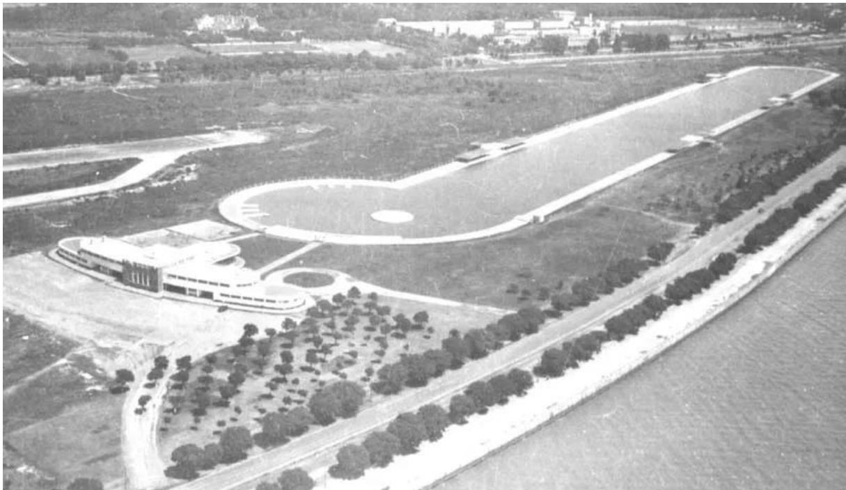
Figura N°3: La pileta del balneario sur con el edificio de confitería y vestuarios.
