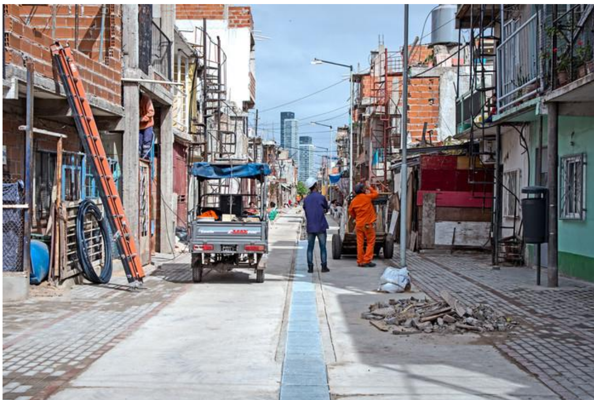
Figura 10. Barrio 31. Calle intervenida por la urbanización. Fuente: www.buenosaires.gob.ar
