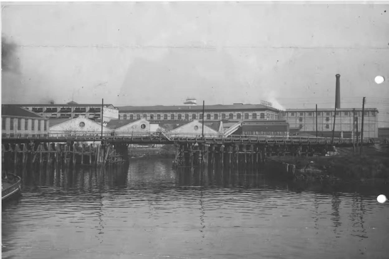
Imagen 15: Frigorífico La Negra y Puente Pueyrredon, 1932.
