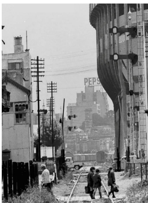
(06) La Boca. Vías Ferroviarias del Ferrocarril Sud, hoy en día Ferrocarril Roca. 1970. Archivo General de la Nación (AGN). 2014.
