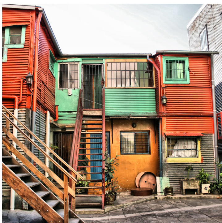
(08) La Boca. Conventillos de la Boca hechos de chapa y madera. Fotografía por Fernando Reis. 2008
