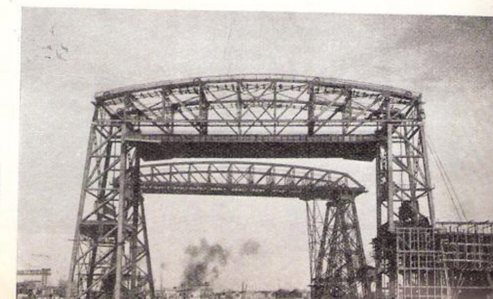
FIG. 32 — Puente terminado con la calzada móvil levantada.
