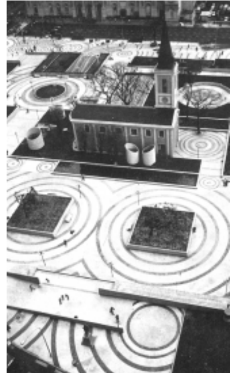
Plaza Dr. Bernardo H. Houssay. Arquitectura de superficie y parquización: Gutiérrez, Peñalba, Liberatori, arqs. Buenos Aires, 1979-80.
