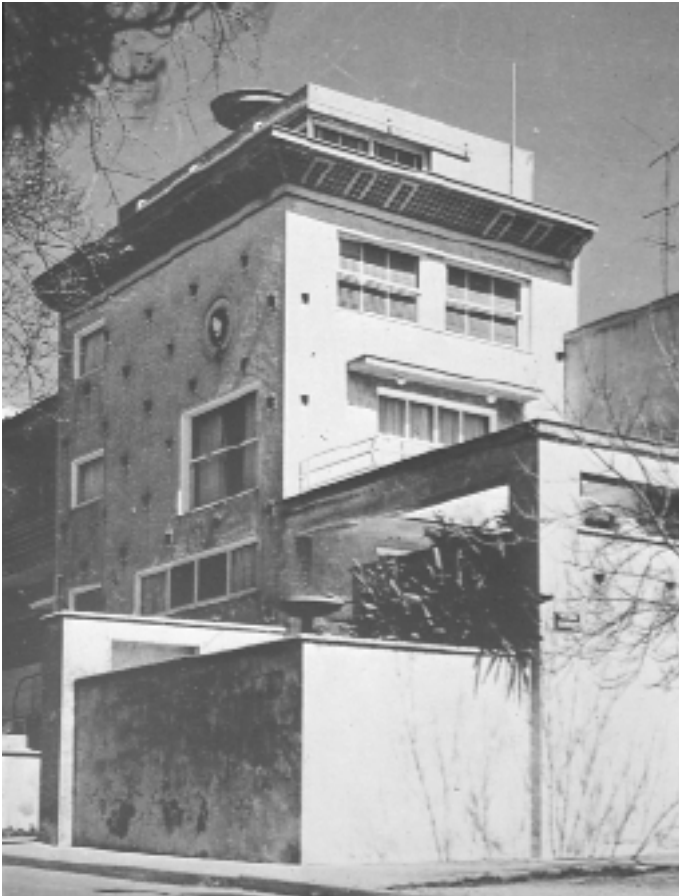
Julio Vilamajó: Vivienda Vilamajó, 1930. Fuente: Vida y obra de Julio Vilamajó , César J. Losteau, Montevideo, 1994.
