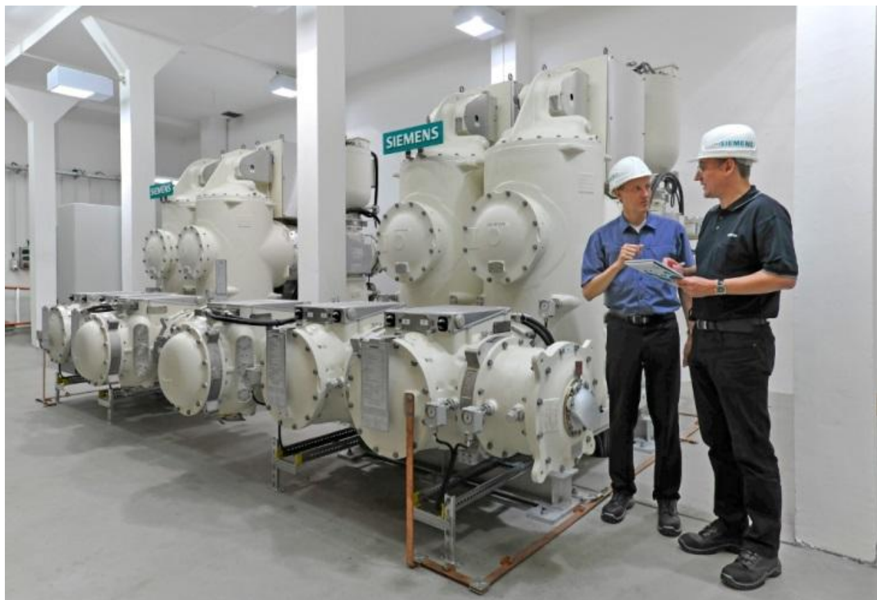
Figura 6: SE GIS 145 kV - Configuración simple barra. Interior.
