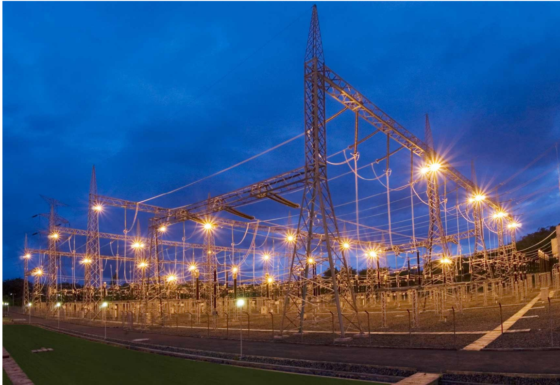
Figura 3: SE de 145 kV convencional (AIS)
