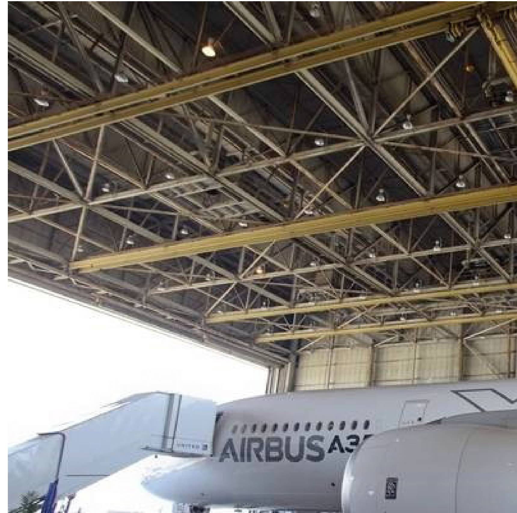
Imagen interior del hangar de United Airlines, Aeropuerto Internacional Chicago O'hare, Chicago, Estados Unidos
