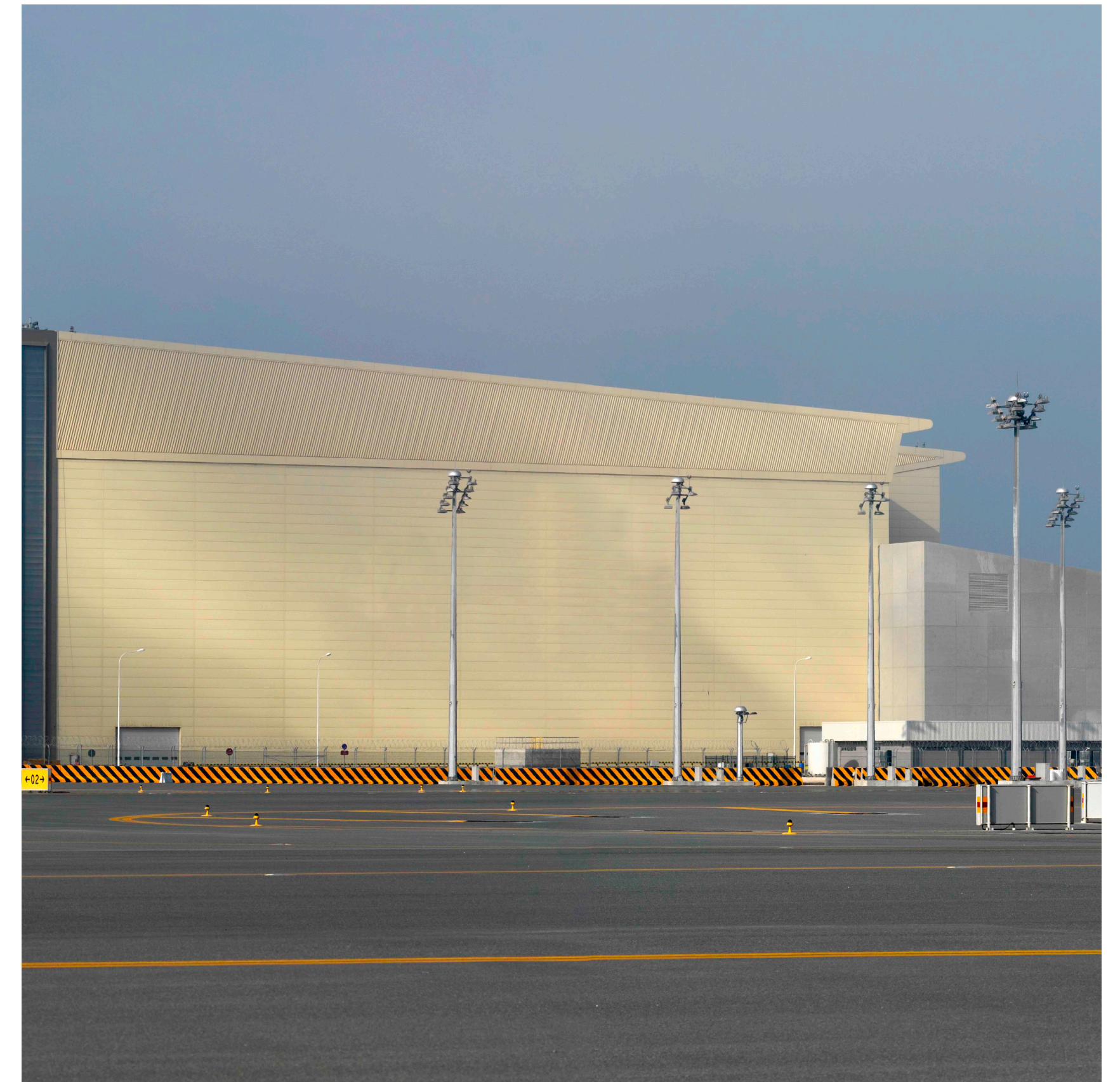
Imagen exterior del hangar de Qatar Airways, Aeropuerto Internacional de Doha, Doha, Qatar
