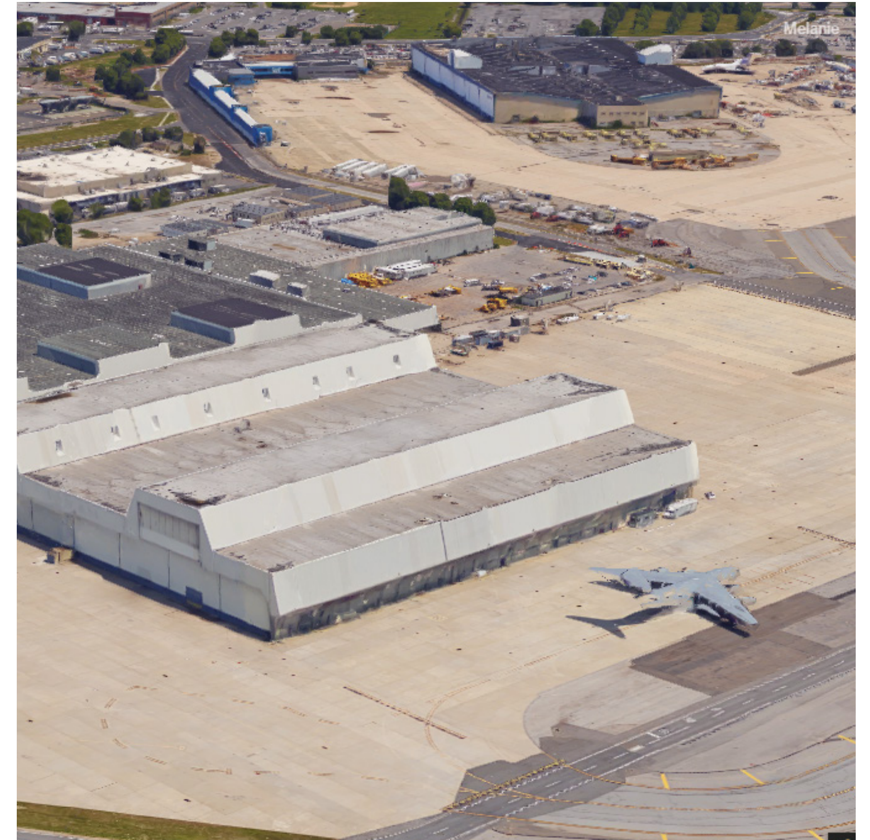
Imagen exterior del hangar de Pan Am World Airlines, Aeropuerto Internacional John F. Kennedy, Nueva York, Estados Unidos
