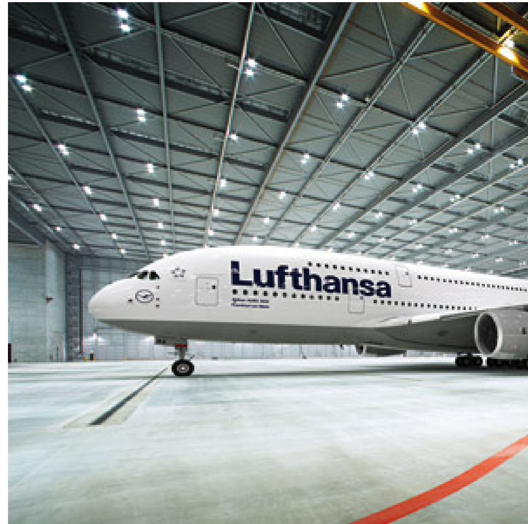
Imagen interior del hangar de Lufthansa Technik, Aeropuerto de Fráncfort del Meno, Frankfurt, Alemania
