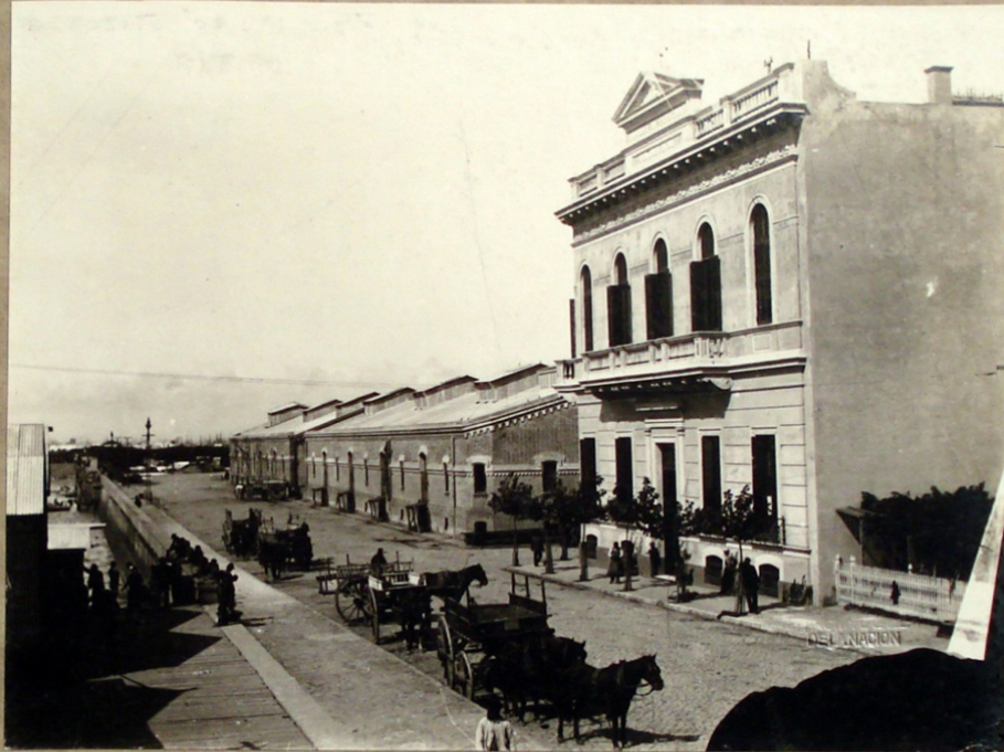
fs. 43 184- *Depósito de las Catalinas - Retiro
