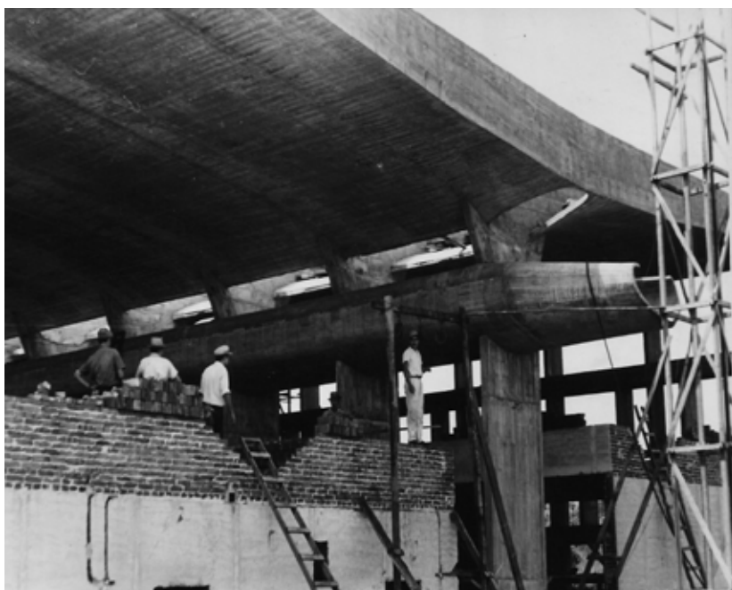
Imágenes 55; 56 y 57: Fotografía tomada durante la construcción del muro de cerramiento lateral y encofrado de cubierta; Etapas de construcción de la sala de música, desde el planteo inicial a la forma concluida
