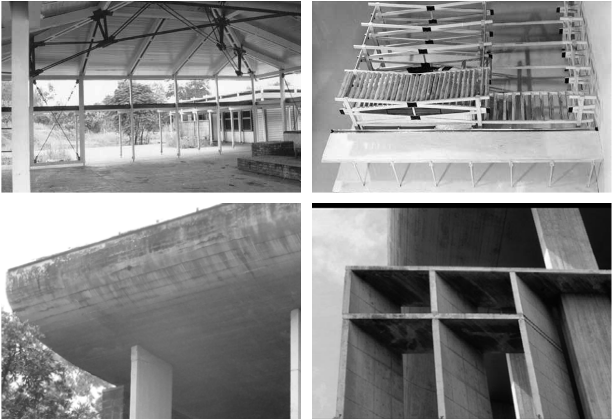
Imagen 7: Vista interior del comedor de una de las escuelas. Cabreadas y detalles resolución de la cubierta. Imagen: Soto y Rivarola 8: Maqueta del concurso para las cuatro escuelas (1956). Soto y Rivarola. Imagen 9: Vista parcial de la cubierta de la Escuela en Alem; Imagen 10: Vista parcial de los parasoles de la fachada del IPS Posadas, ambas obras de Soto y Rivarola
