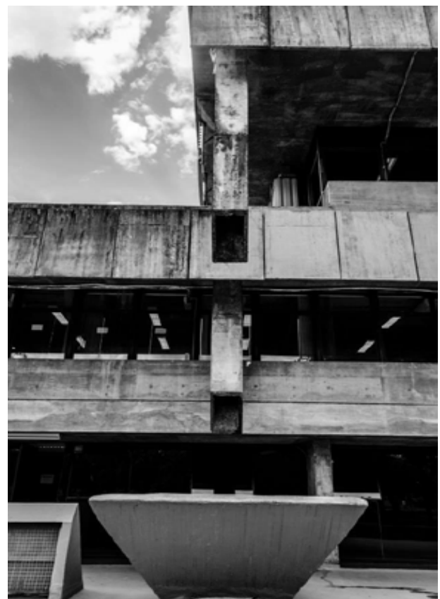
Detalles de la canaleta del Palacio de Justicia en Brasilia, obra de O. Niemeyer; detalle receptáculo tipo bachea del edificio del ectorado de la Universidad de Brasilia.
