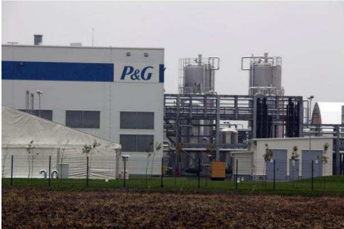
Planta de P&G Pilar – Sección de producción Líquidos Home Care
