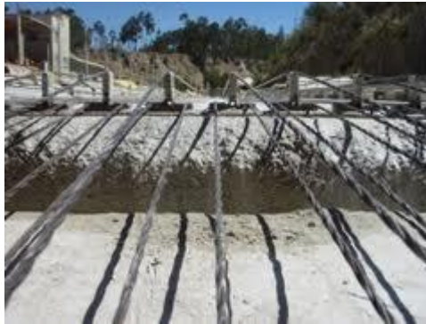
Figura 14 Estructura de hormigón post-tensado in situ
