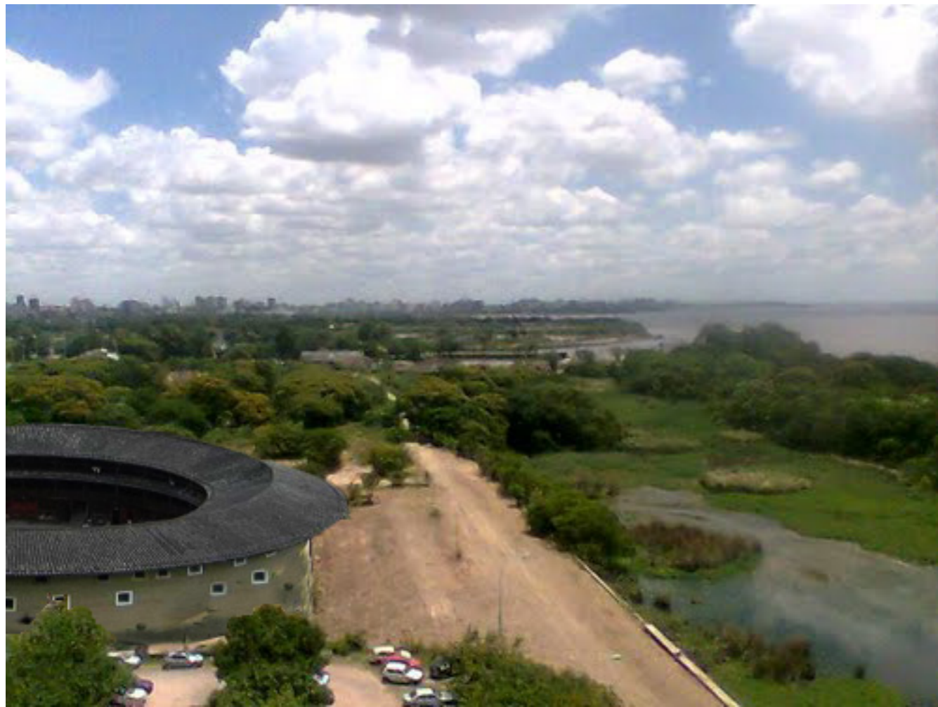
CIUDAD UNIVERSITARIA DE BSAS - SOBRE CIMIENTOS DEL PABELLÓN 4
