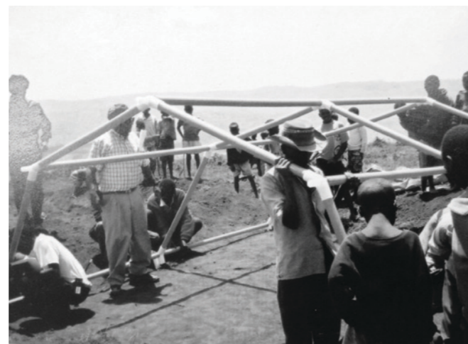
Proyecto de refugio de emergencia de Shigeru Ban para refugiados en Rwanda 1995. UNHCR proporciona membrana de plástico y postes de aluminio como refugio temporal para 2 000 000 desplazados. Las víctimas vendían los postes de aluminio y en para la estructura de la carpa cortaban árboles lo que llevó a un problema de deforestación. Shigeru Ban contacta a la ACNUR y es nombrado asesor tras proponer el uso de tubos de cartón para evitar la deforestación. (Ban,)
