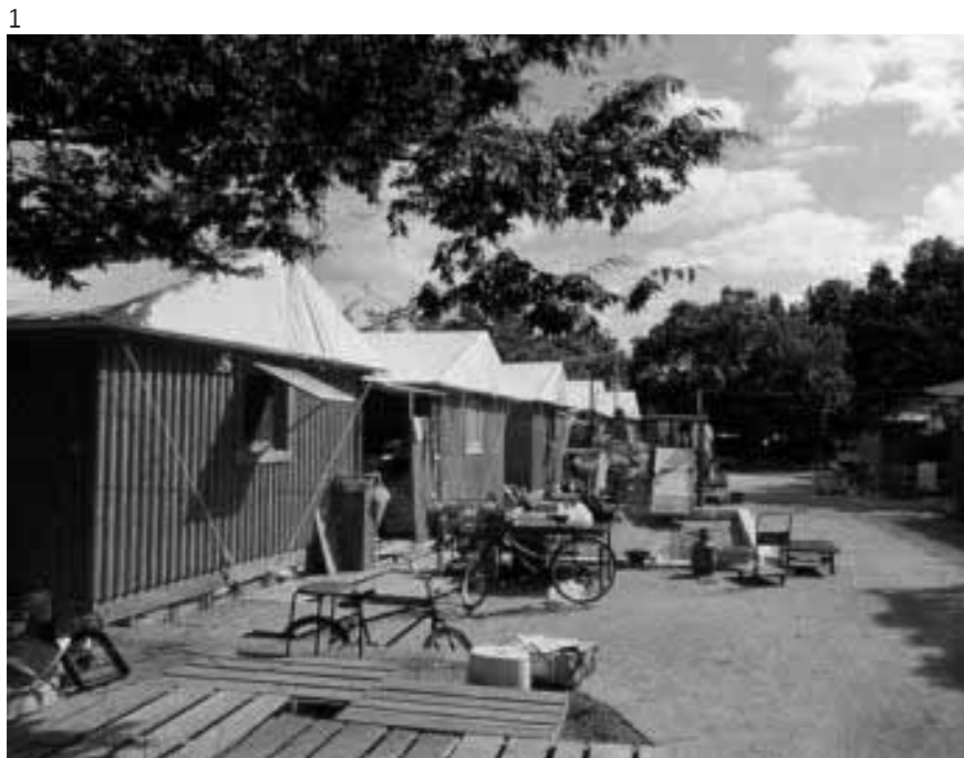
1. Davis, Ian. Arquitectura de emergencia. 2. Casas de tubos de carton para refugiados en Kobe por Shigeru Ban en 1995. Tamaño de planta 4x4m con tubos de carton de 108mm de diametro y 4mm de espesor. Se pueden conectar dos unidades para hacer una mas grande. (Ban, 132)
