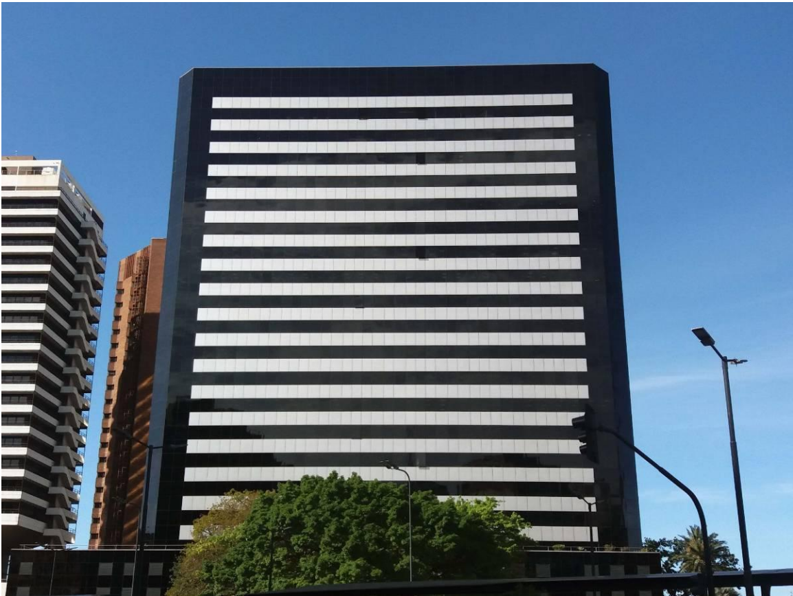
Figura 9. Frente del edificio a alquilar.
