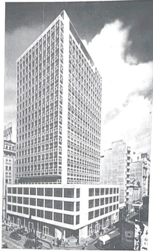
O majestoso Palácio do Comércio receberá esquadrias metálicas de fabricação A. M. C.
