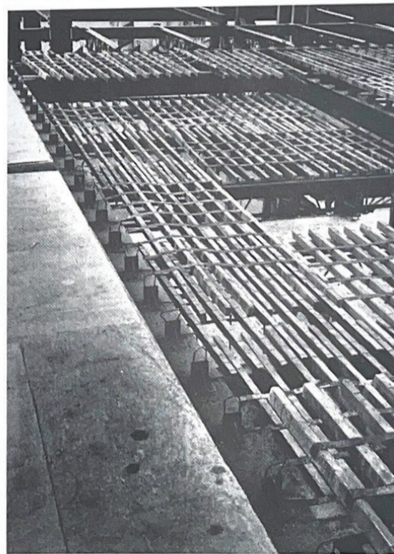
Foto 2 — Vista parcial das formas das lajes, vendo-se à esquerda da viga o painel pronto para receber armação.
