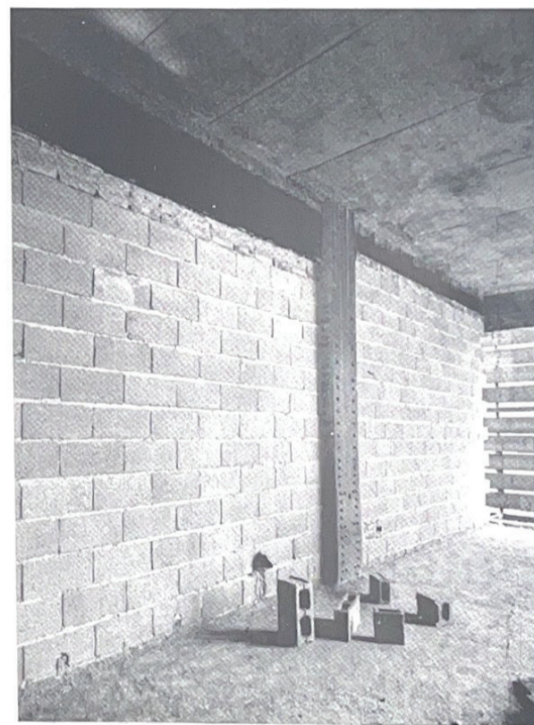
Detalhe dos blocos de concreto aplicada junto a estrutura metálica.
