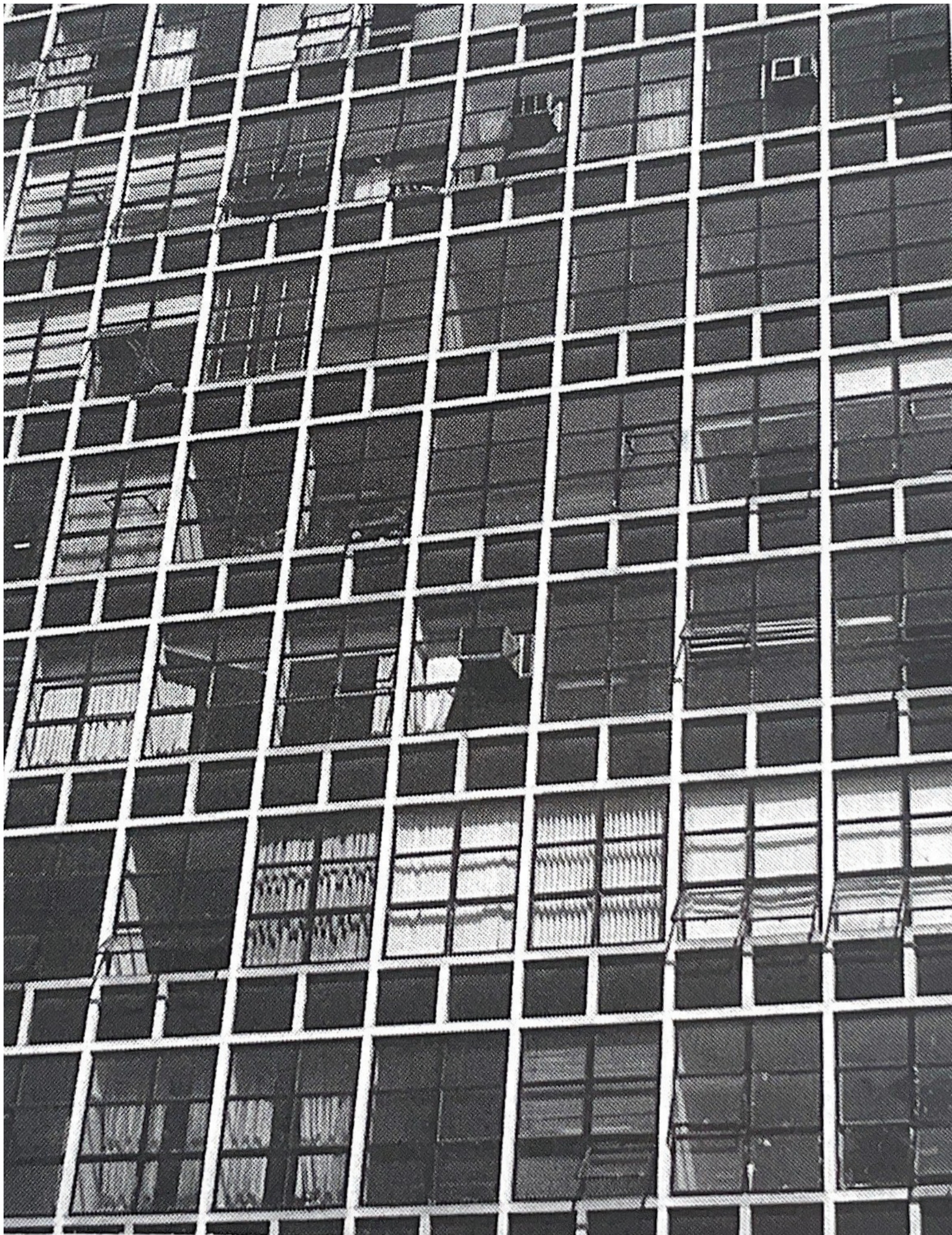
Fotografía de un sector de la fachada de torre del Palacio de Comercio. Arq.Lucjan Korngold Sao Paulo. Autor: H Becherini. Fuente:Matto Dias, L. A. D. (2006). Estructuras de Acero: conceptos, técnicas y lenguaje. Brasil: Zigurate.
