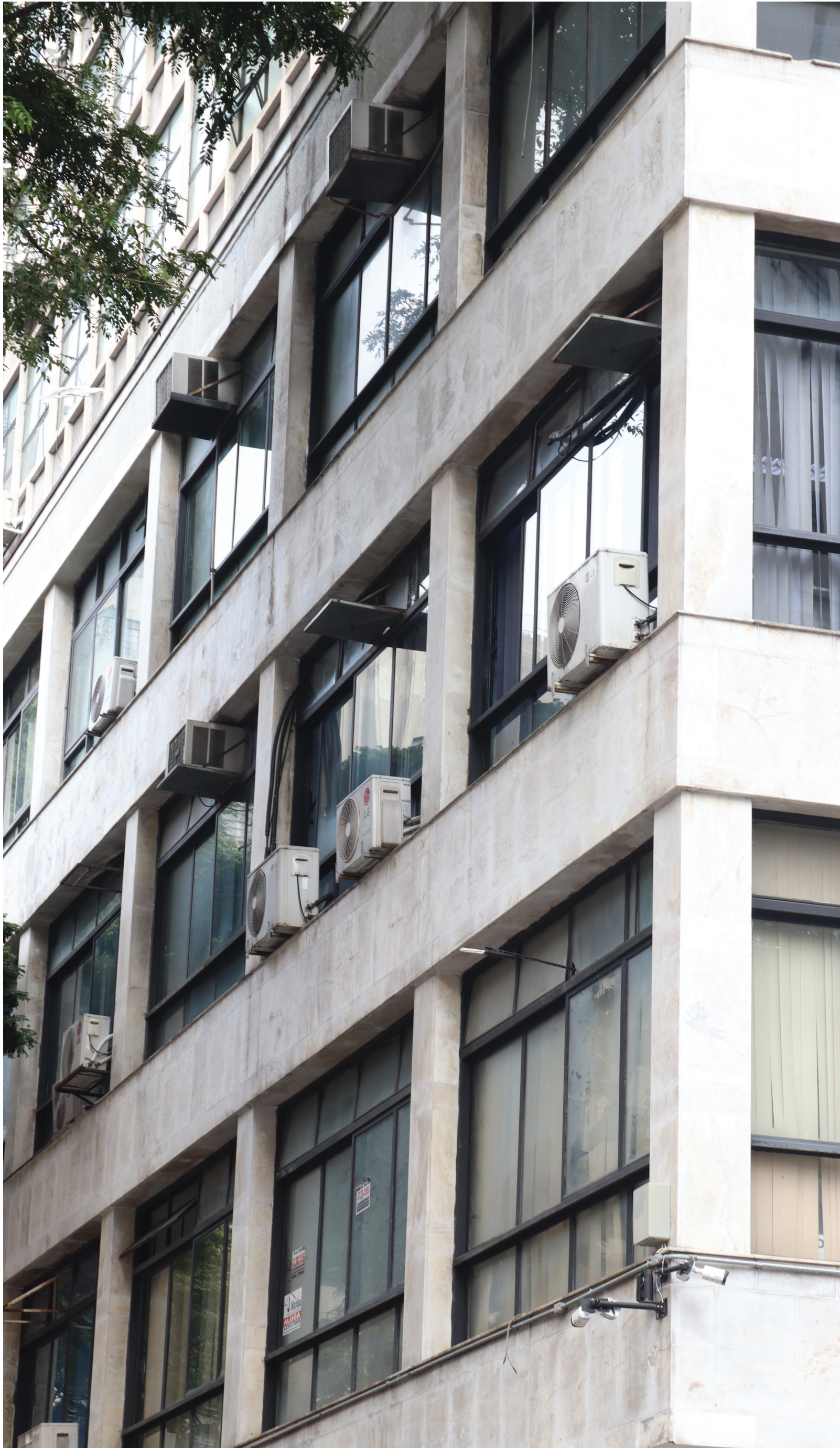
Fotografía detalle de fachada basamento Palacio de Comercio. Autoría propia.
