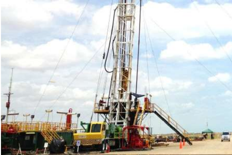
Figura 11 Equipo Workover para reparación de fallas ( Discovery Energy Services, 2020 )
