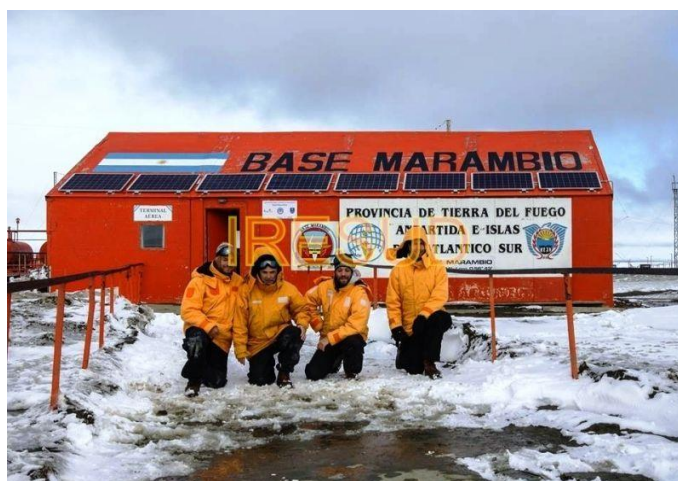
Figura 19: Paneles fotovoltaicos en Base Marambio en la Antártida. Fuente: (IRESUD, 2019)
