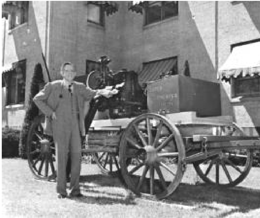
Figura 3: Primera Camión para Cementar construido por Erle P Halliburton
