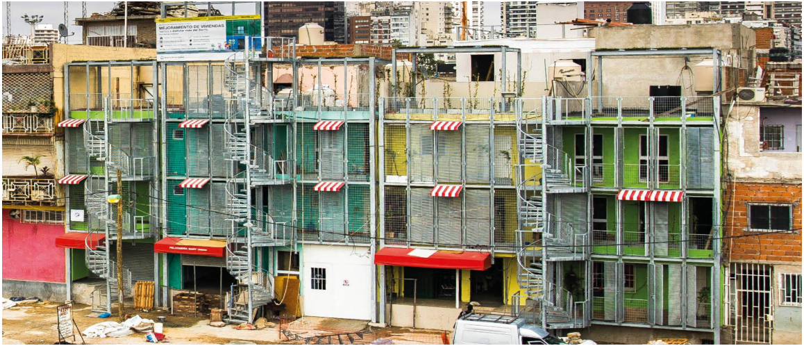
Foto 1: Mejoramiento de vivienda Mza. G1 Playón Oeste. Fuente: GCBA.
