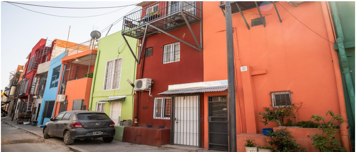
Foto 2: Mejoramiento de vivienda Mza. 22 YPF. Fuente: GCBA.
