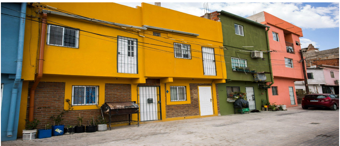
Foto 3: Mejoramiento de vivienda Mza. 12 Cristo Obrero. Fuente: GCBA.
