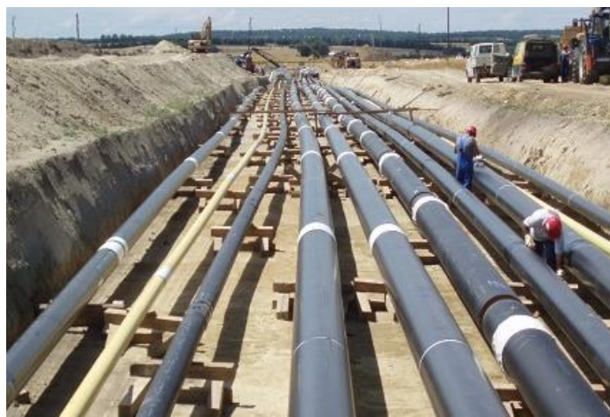
Figure 14: Instalación de tubería Line Pipe para distribución de hidrocarburos
