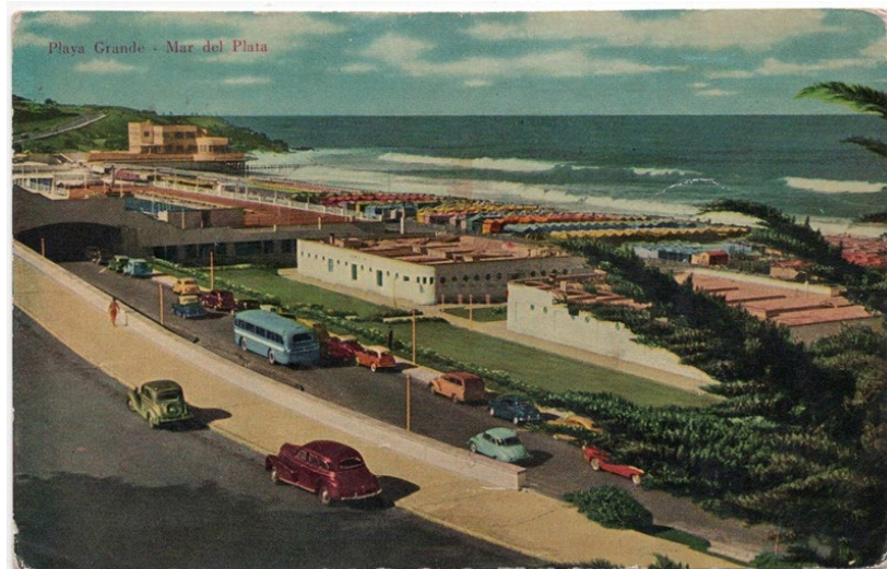
Figura 2. Tarjeta postal urbanización Playa Grande, 1950. Autor: Dirección Provincial de Arquitectura, 1939. Fotografía: desconocido. Fuente: fotosantiguasmardelplata.blog
