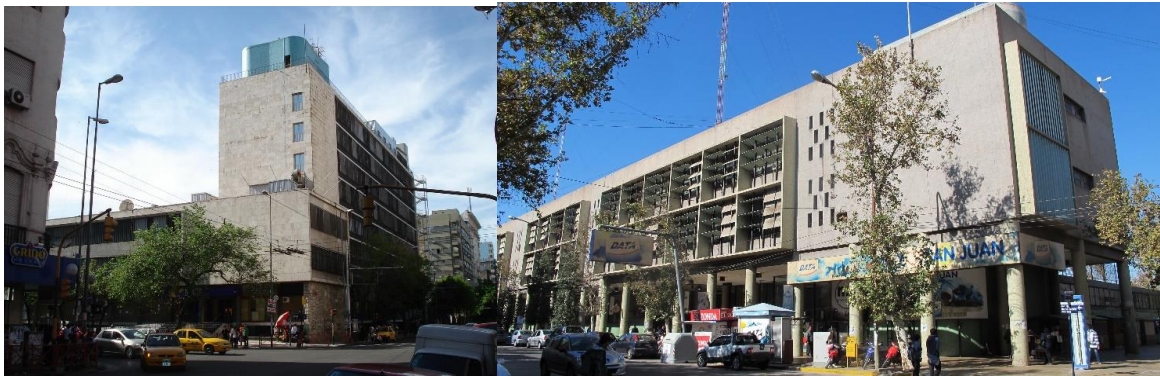
Imagen III.16 Esquina edificio de CyT Córdoba . Foto: J. Arroyo, 2010 Imagen III.17 Esquina Correo de San Juan . Foto: M. Risso y R. Gorostidi, 2012
