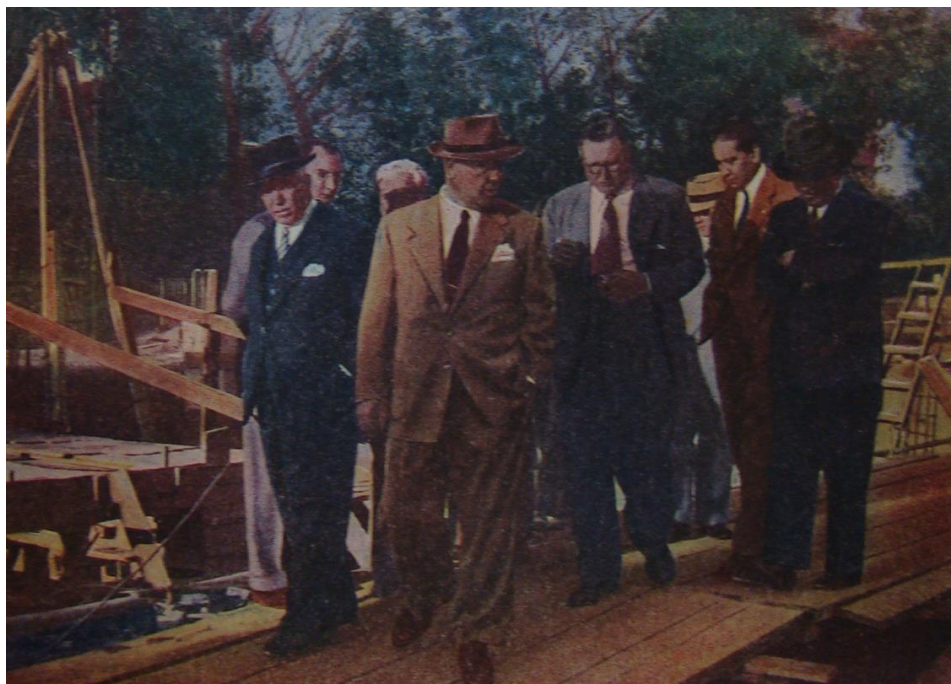
Imagen III.35 Visita a las obras del Edificio de Correos y Telecomunicaciones de Mendoza. Ministro de Comunicaciones Oscar Nicolini, Dr. Rafael Tabanero, Ing. Crocco y Sr. José María Caffaro Rossi. Fuente: Revista de Correos y Telecomunicaciones, abr-may.1949
