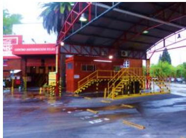
Figura 2.10: Unidad Operativa Pilar
