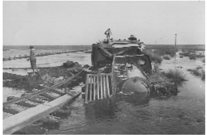
Vuelco de un convoy ferroviario en la provincia de Santa Fe, debido al socavamiento del terraplén por la crecida del río. Ca. 1915.
