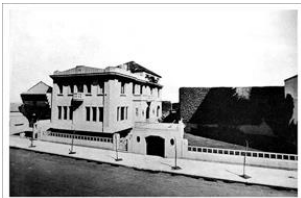
Fig. 3: Casa Virasoro, arquitecto Alejandro Virasoro, Buenos Aires, 1925. Fuente: Archivo digital Universidad de Rosario http://www.biblioteca.fapyd.unr.edu.ar/leaves/archivo/arquitectura-argentina/mas-info/casa-calle-aguero.htm (consultada el 10 de junio 2020)
