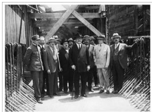
Fig. 22: Intendente Municipal, José Luis Cantilo (1928-1930), y dirigentes de la CIAE en uno de los cuatro túneles de refrigeración durante la construcción de la Usina en Puerto Nuevo. Circa 1929. Fotografía: Autor desconocido. Fuente: Archivo General de la Nación, Departamento Documentos Fotográficos. Fondo: Acervo Gráfico Audiovisual y Sonoro. Serie Repositorio Gráfico. Caja N°1500, N° de inventario 59.086.
