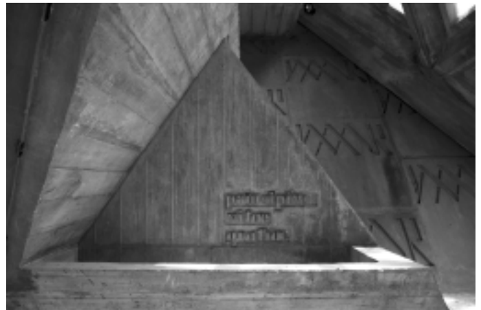
Iglesia de Soca. Fachada norte. Baptisterio exterior e interior.
