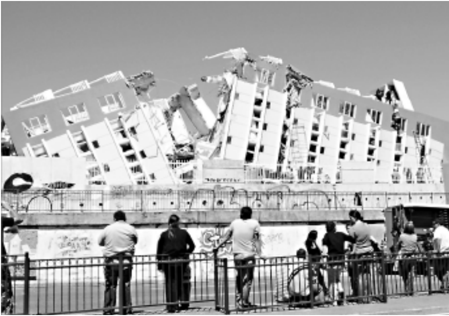
Derrumbe del edificio «Alto Bío Bío» en Concepción. En La Tercera , 5 de marzo de 2010, p. 15. Foto: Camila Lasalle (reproducción autorizada).
