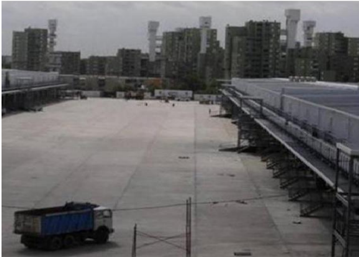
Nuevo centro de transferencia de cargas colindante a Complejo Habitacional de Villa Soldati
