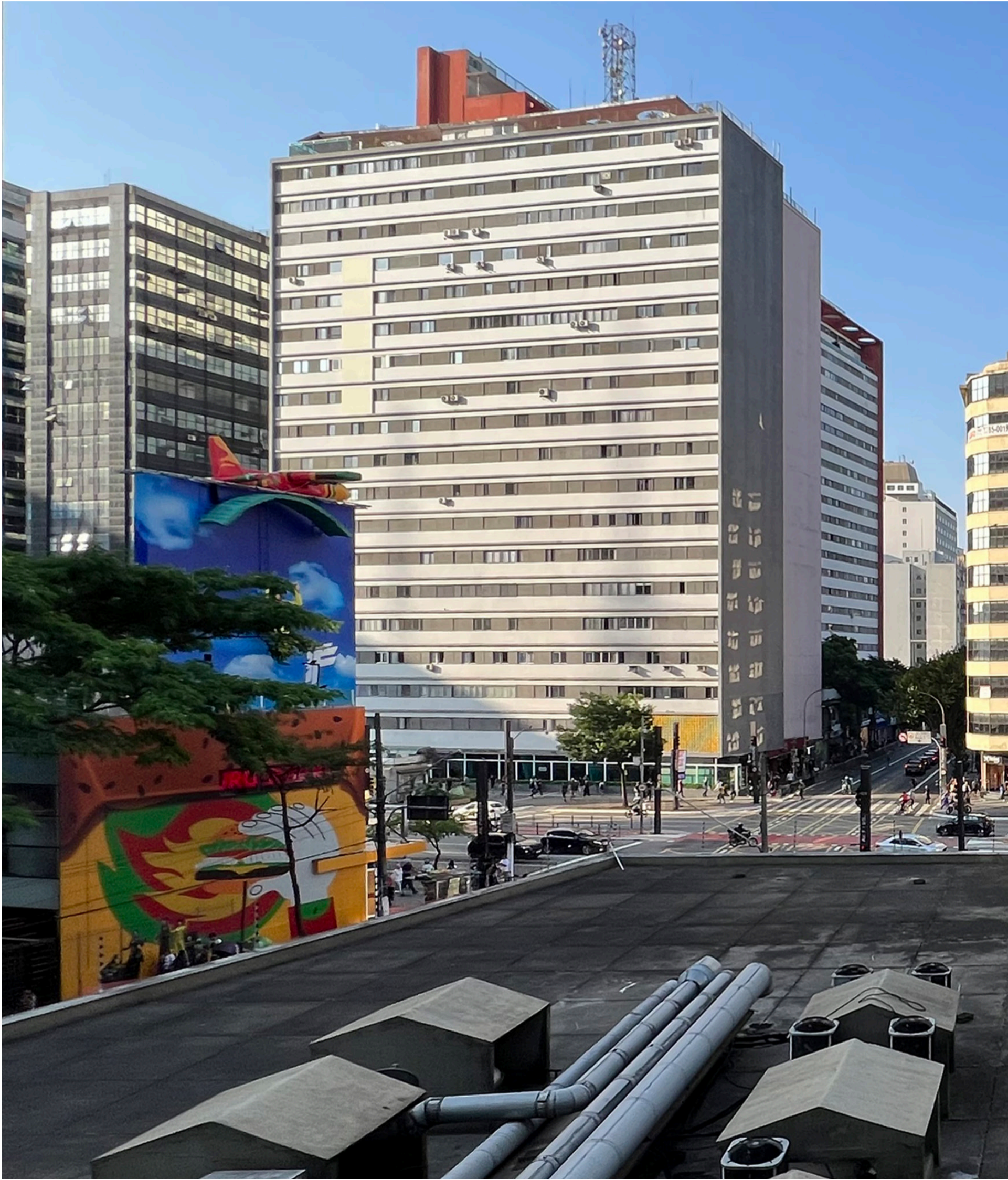
Vista desde el interior de la torre Fuente: aut
