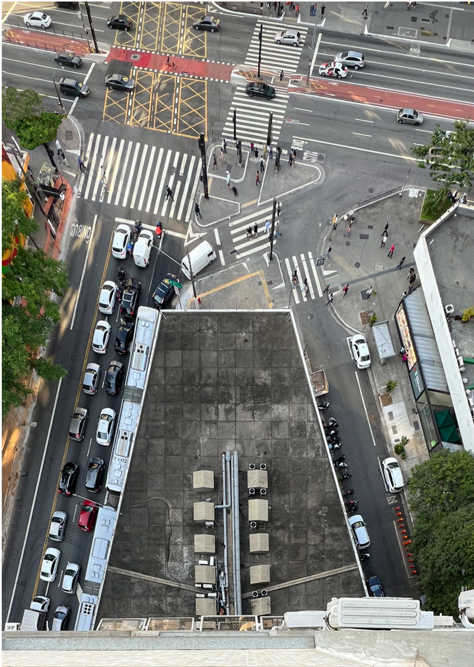
Imagen contrapicada desde la torre hacia la terraza inaccesible del basamento Fuente: autoría propia
