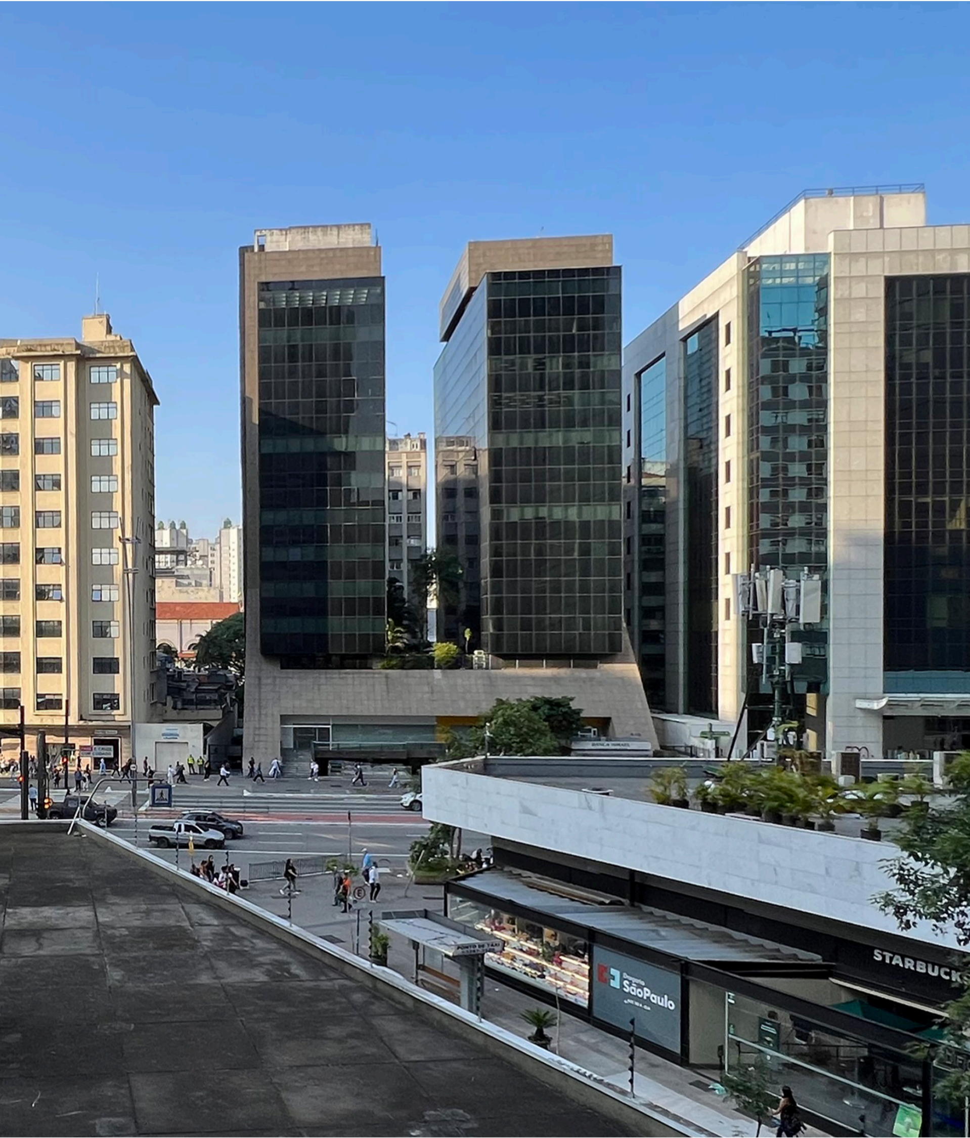
hacia la terraza de instalaciones propia
