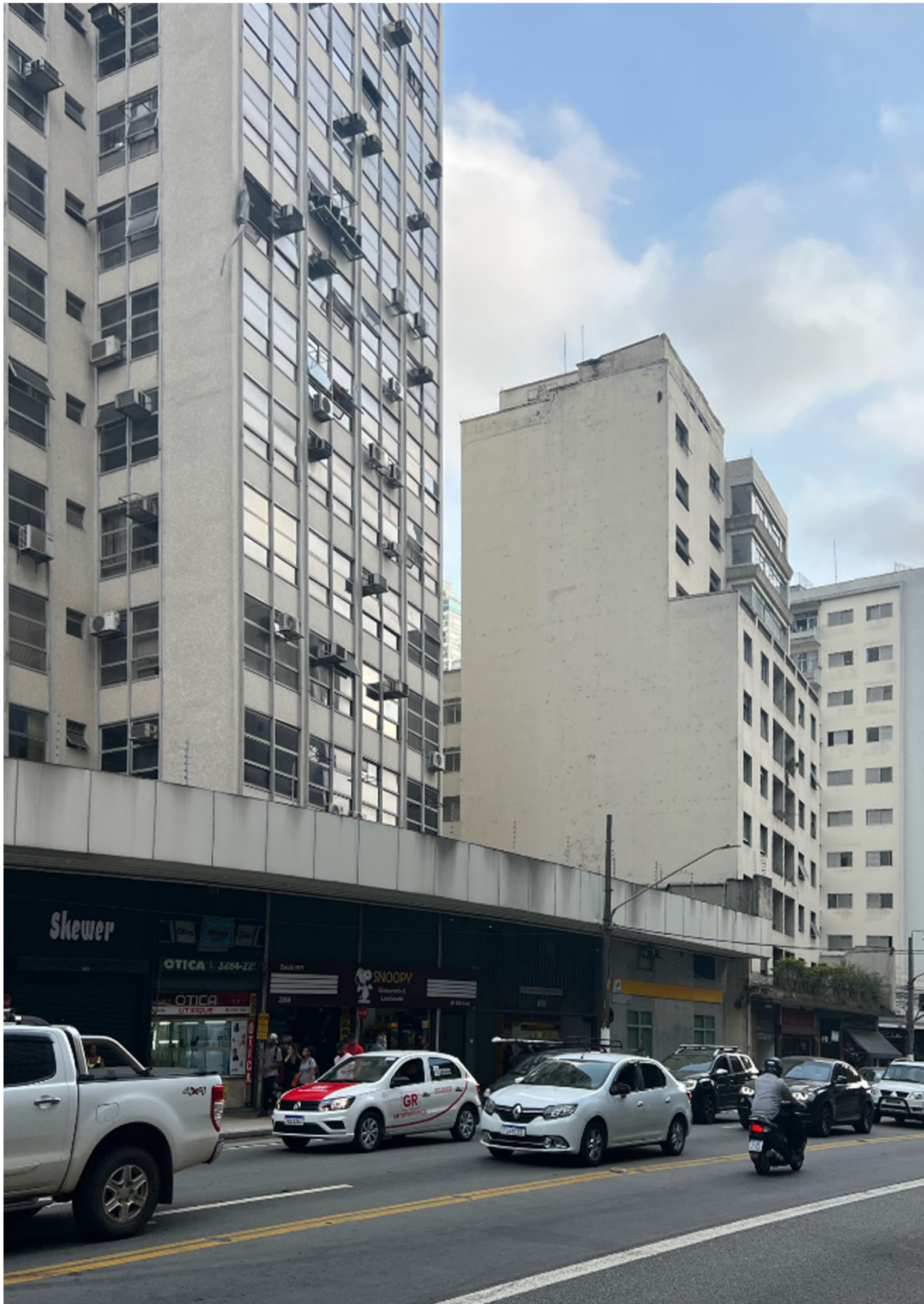
Medianera vista desde la Avenida Brigadeiro Fuente: autoría propia
