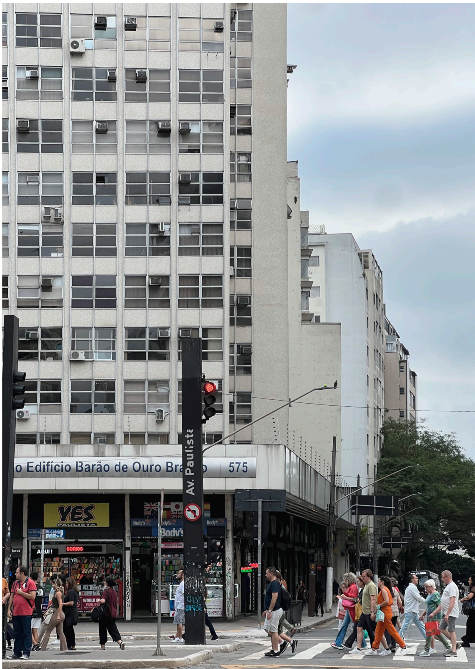
Condominio Edificio Barão de Ouro Branco desde la Avenida Paulista Fuente: autoria propia
